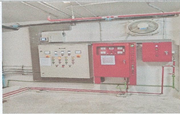
รูปที่ 3-40 ระบบมิเตอร์ไฟฟ้าสำหรับห้องเครื่องสูบน้ำ ดับเพลิง
