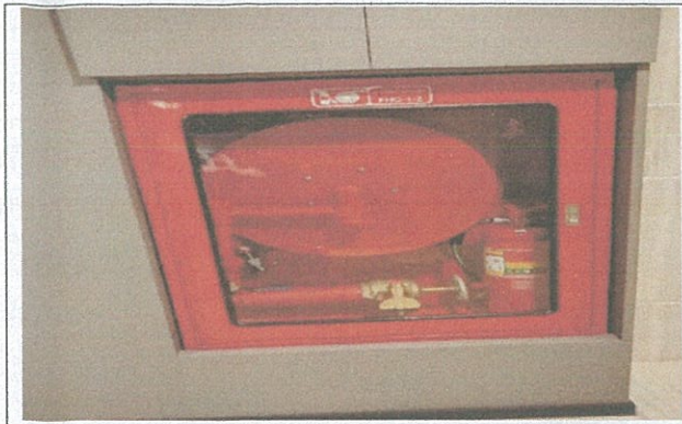
รูปที่ 3-50 ตู้เก็บสายดับเพลิง (Fire Hose Cabinet)
