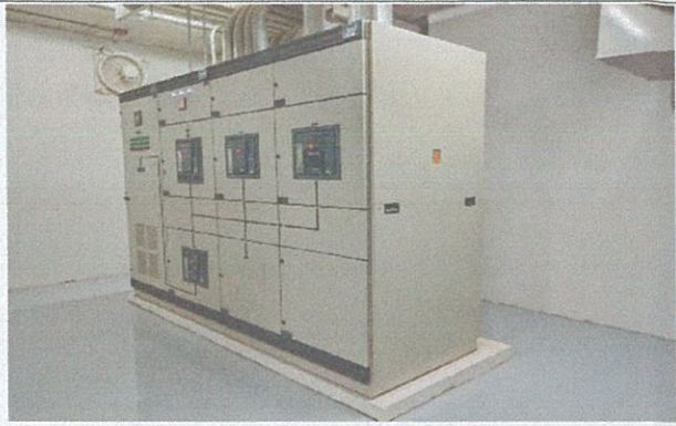
รูปที่ 3-33 ระบบมิเตอร์ไฟฟ้าภายในห้องเครื่องไฟฟ้า
