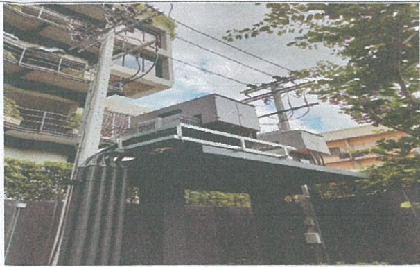
รูปที่ 3-38 หม้อแปลงไฟฟ้าที่มีการติดป้ายอันตราย ไฟฟ้าแรงสูง
