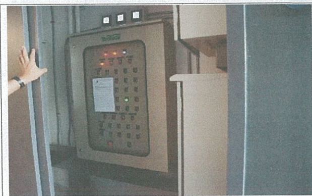
รูปที่ 2-13 ระบบมิเตอร์ไฟฟ้า สำหรับระบบบำบัดน้ำเสีย
