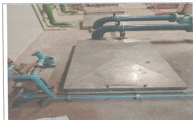
รูปที่ 2-14 ถังสำรองน้ำใต้ดิน
