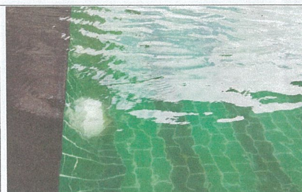
รูปที่ 3-25 ไฟส่องสว่างภายในสระว่ายน้ำ
