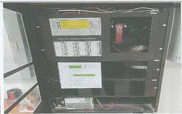
รูปที่ 3-52 แผงควบคุม (Fire Alarm Control Panel : FCP)
