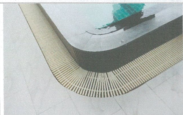
รูปที่ 3-31 รางระบายน้ำล้นมีฝาปิดรอบสระว่ายน้ำ
