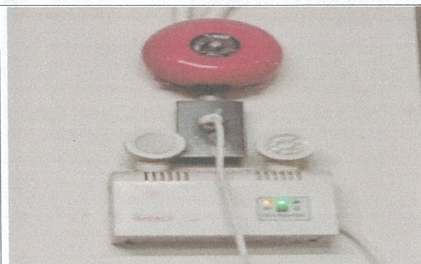
รูปที่ 3-42 กริ่งสัญญาณแจ้งเหตุ (Fire Alarm Bell)
