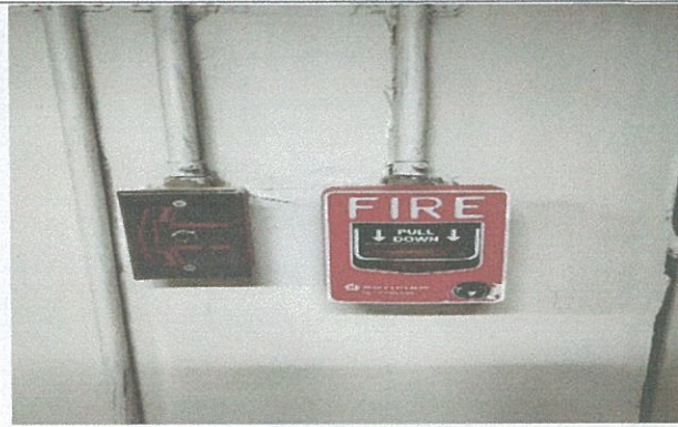
รูปที่ 3-41 เครื่องแจ้งเหตุโดยใช่มือดึง (Manual Station)
