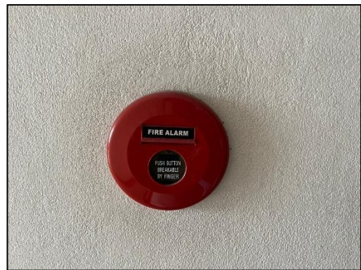
ภาพที่ 28 Fire Alarm Manual Station
