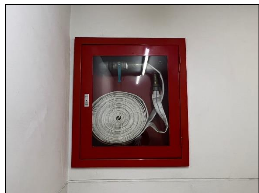
ภาพที่ 30 ตู้อุปกรณ์ดับเพลิง
