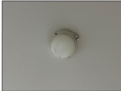
ภาพที่ 62 Heat Detector
