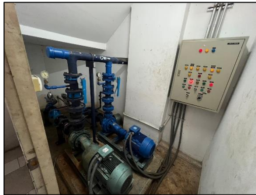
ภาพที่ 38 เครื่องสูบน้ำจากถังเก็บน้ำชั้นใต้ดินไปยังถังเก็บน้ำชั้นดาดฟ้า
