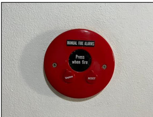
ภาพที่ 63 Fire Alarm Manual Station
