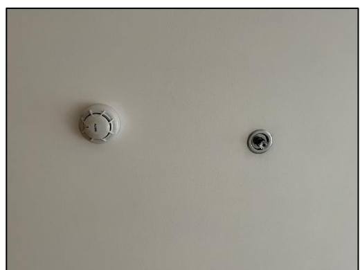
ภาพที่ 38 Smoke Detector และ Heat Detector
