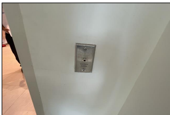
ภาพที่ 40 โทรศัพท์แจ้งเหตุฉุกเฉินเพลิงไหม้
