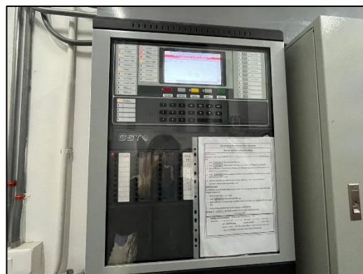
ภาพที่ 37 แผงควบคุม (Fire Alarm Controlpanel)
