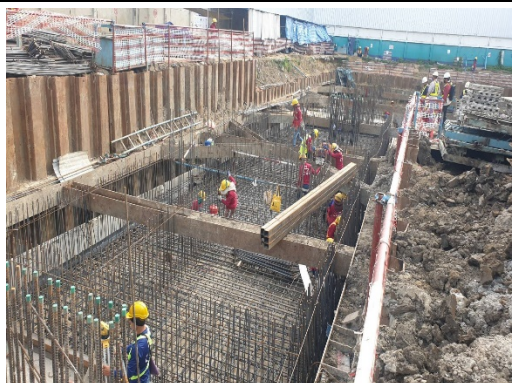
รูปที่ 7 ร้ว Metal Sheet รอบโครงการ
