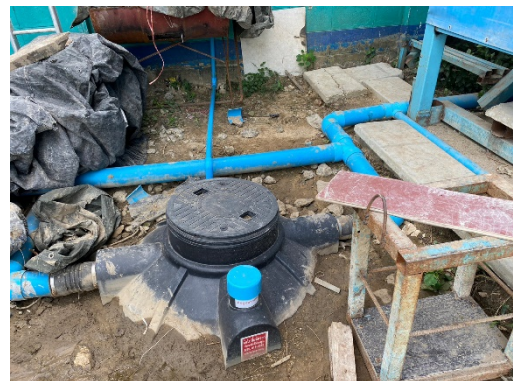
รูปที่ 34 ระบบบำบัดน้ำเสีย
