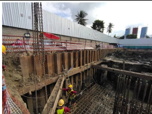
รูปที่ 7 ร้ว Metal Sheet รอบโครงการ
