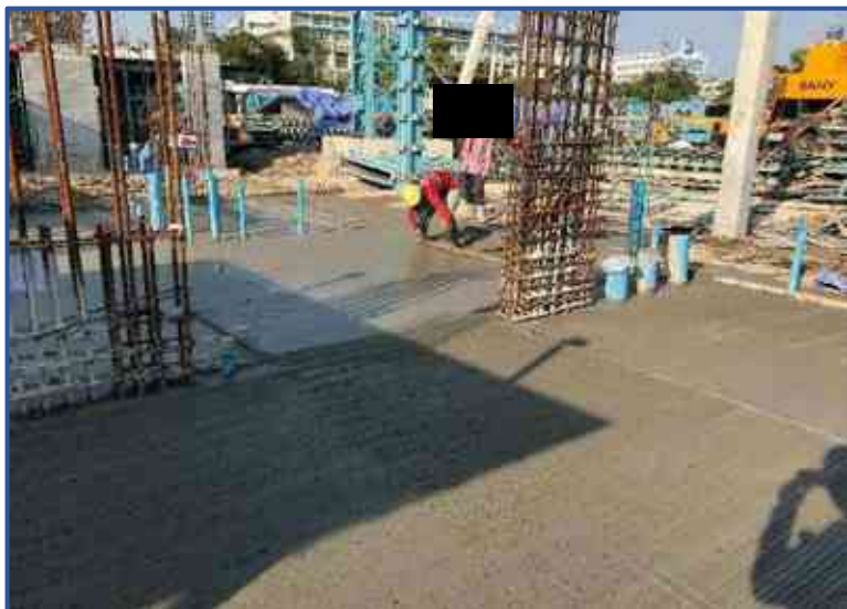
งานกวาดหน้าลายพื้น ในกรณีที่มีพื้นมี Finishing ภายหลัง
