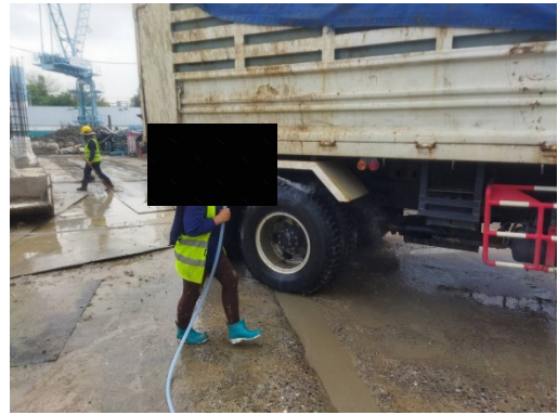
รูปที่ 19 เจ้าหน้าที่ฉีดล้างล้อรถบรรทุก
