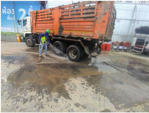
รูปที่ 19 เจ้าหน้าที่ฉีดล้างล้อรถบรรทุก
