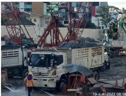
ภาพที่ 5-12 ชีดล้างล้อรถบรรทุกด้วยเครื่องฉีดน้ำแรงดันสูง และปิดคลุมท้ายกระบะบรรทุกก่อนออกจากโครงการ
