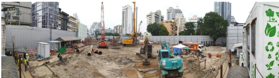
ภาพที่ 5-8 การก่อสร้าง Diaphragm Wall
