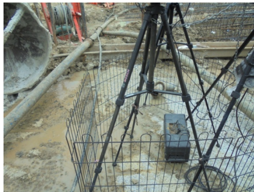
(อุปกรณ์ตรวจวัดความสั่นสะเทือนเคลื่อนย้ายไปตามทิศทางของการทำเสาเข็ม)
