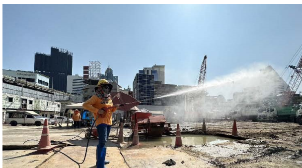
ภาพที่ 5-27 ฉีดพ่นละอองน้ำเพื่อลดฝุ่นละออง
