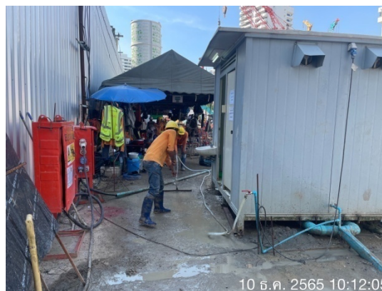
ภาพที่ 5-39 ตรวจสอบท่อพีวีซี ท่อน้ำประปา ก๊อกน้ำ บริเวณห้องน้ำ ไม่มีรั่วซึม และทำความสะอาดห้องน้ำ
