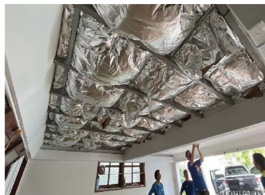
งานติดตั้งอุปกรณ์ดูดซับเสียงบ้านเลขที่ 3
