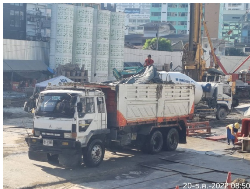
ภาพที่ 5-12 ชีดล้างล้อรถบรรทุกด้วยเครื่องฉีดน้ำแรงดันสูง และปิดคลุมท้ายกระบะบรรทุกก่อนออกจากโครงการ
