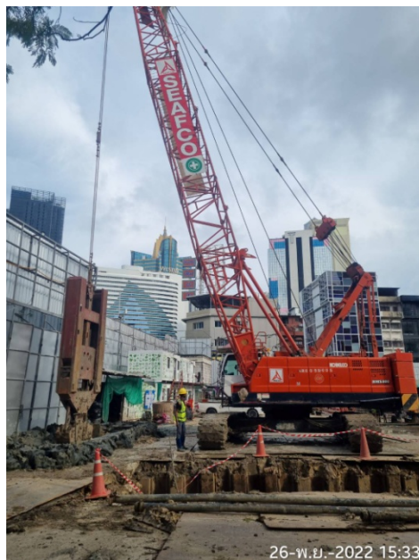
ภาพที่ 5-11 กิจกรรมการทำเสาเข็มเจาะ และระบบป้องกันดินพัง
