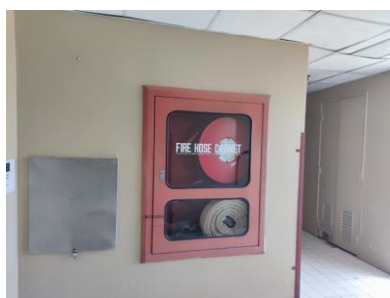
ถังดับเพลิงและระบบดับเพลิงในส่วนอาคารพัก
