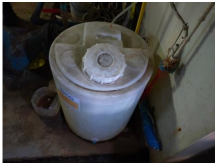
ระบบเติมคลอรีนถังพักน้ำใช้ Ground Water Tank
