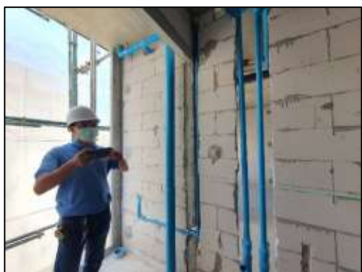
ภาพที่ 35 เจ้าหน้าที่ตรวจสอบการรั่วซึม ของระบบท่อประปา
