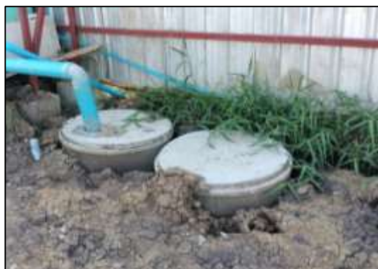
ภาพที่ 25 บ่อเกรอะ-กรองไร้อากาศ
