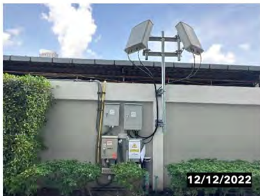
ภาพที่ 2-18 การเดินสายไฟฟ้า สายสัญญาณต่างๆ มีความเรียบร้อย และถูกต้องตามมาตรฐาน
