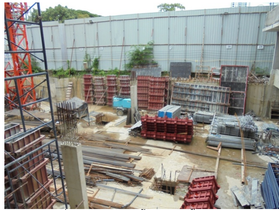
5-4 ทำระบบกันดินพัง Sheet Pile และปูพื้นด้วยเหล็กหนาเป็นทางวิ่งรถ ปัจจุบัน เป็นพื้นคอนกรีตทั้งหมด
