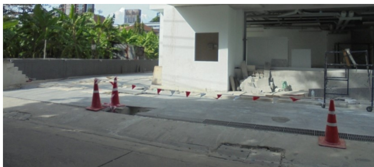
5-3 รั้วด้านหน้าเป็นที่ ล้างล้อ และทำความสะอาดเป็นประจำทุกวัน
