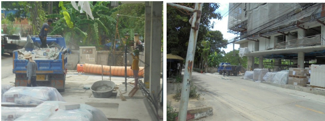
ภาพที่ 5-29 เก็บเศษวัสดุก่อสร้างออก และปิดคลุมกระบะบรรทุกไว้ก่อนออกจากโครงการ
