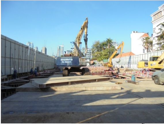
5-4 ทำระบบกันดินพัง Sheet Pile และปูพื้นด้วยเหล็กหนาเป็นทางวิ่งรถ ปัจจุบัน เป็นพื้นคอนกรีตทั้งหมด
