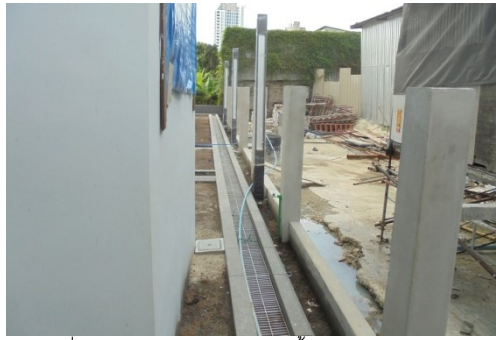
ภาพที่ 5-18 ตรวจสอบวางระบายน้ำไม่มีตะกอนดินสะสม
