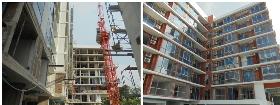
ภาพที่ 5-23 ติดตั้งเครนให้แขนเครนอยู่ภายในโครงการ ปัจจุบันนำออกแล้ว
