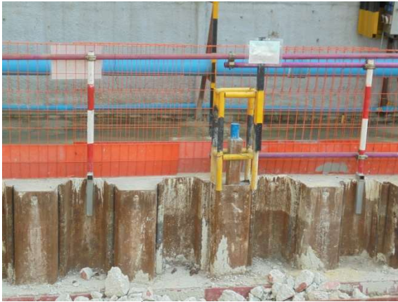
ภาพที่ 5-19 กดSheet Pile ระบบป้องกันดินพัง และติดตั้ง Inclinator ตรวจสอบการเคลื่อนตัวของดิน
