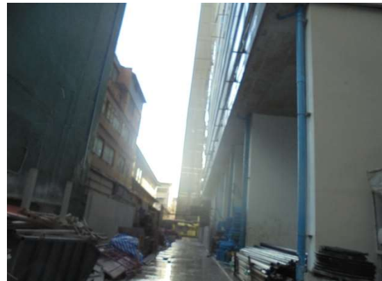
ภาพที่ 5-28 ตักเศษวัสดุก่อสร้างขนออกไปสู่ภายนอกโครงการและติดตั้งสเปรย์น้ำมา่น้ำบริเวณด้านหลังที่ติดกับอาคารข้างเคียง
