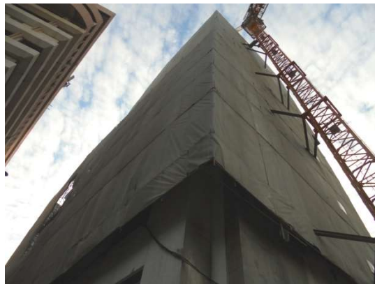
ภาพที่ 5-20 ปิดคลุมอาคารตามชั้นความสูงที่ก่อสร้างไว้ และใช้ทาวเวอร์ไครน
