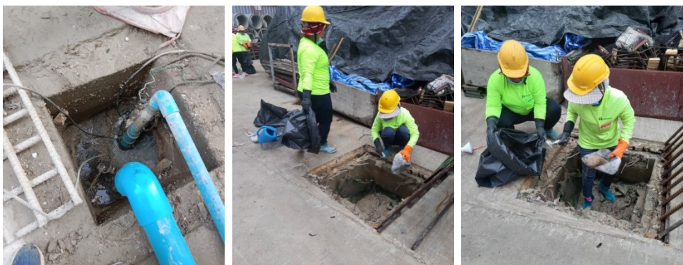
5-12 ล้างทำความสะอาดบ่อพักตะกอนและท่อนระบายน้ำ
