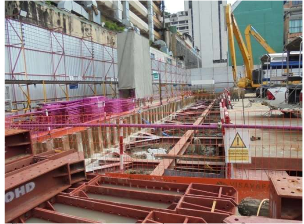
ภาพที่ 5-19 กดSheet Pile ระบบป้องกันดินพัง และติดตั้ง Inclinator ตรวจสอบการเคลื่อนตัวของดิน
