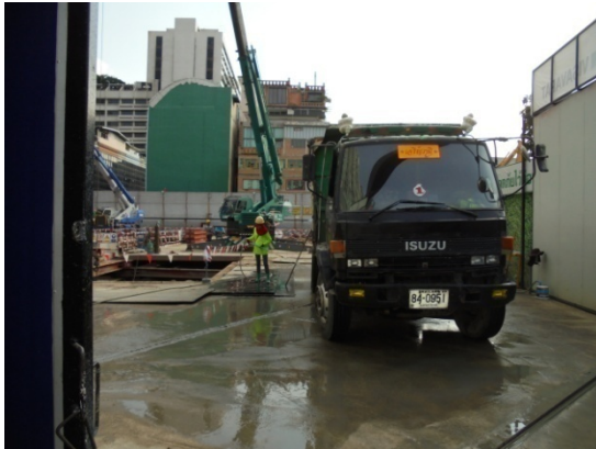
5-8 ขีดล้างล้อรถบรรทุกก่อนออกจากโครงการด้วยสายฉีดน้ำแรงดันสูง
