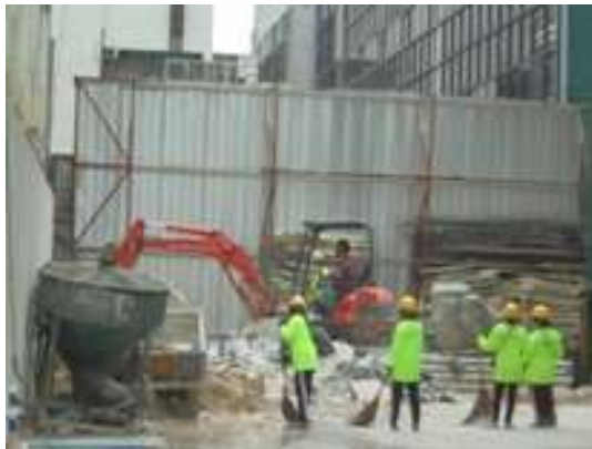
ภาพที่ 5-28 ตักเศษวัสดุก่อสร้างขนออกไปสู่ภายนอกโครงการและติดตั้งสเปรย์น้ำมา่น้ำบริเวณด้านหลังที่ติดกับอาคารข้างเคียง
