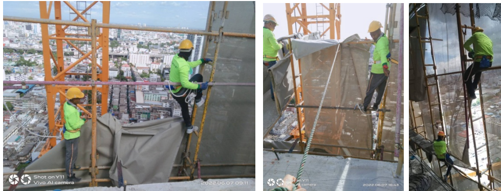
ภาพที่ 5-22 สวมใส่อุปกรณ์ป้องกันภัย เช่น เข็มขัดนิรภัยในการขึ้นที่สูง
