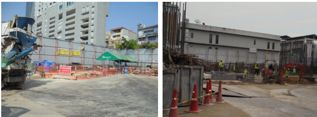
5-4 ปูแผ่นเหล็กหนาบริเวณพื้นที่โครงการ และวางกันตกช่วงการขุดดิน
