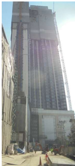
ภาพที่ 5-20 ปิดคลุมอาคารตามชั้นความสูงที่ก่อสร้างไว้ และใช้ทาวเวอร์ไครน
