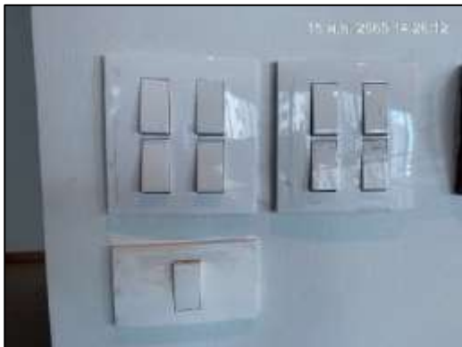
ภาพที่ 25 สวิตช์เปิด-ปิดเฉพาะจุด
