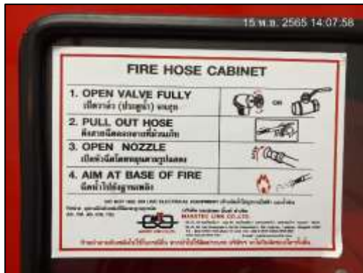
ภาพที่ 57 (ต่อ) อุปกรณ์ดับเพลิงและวิธีการใช้งาน
