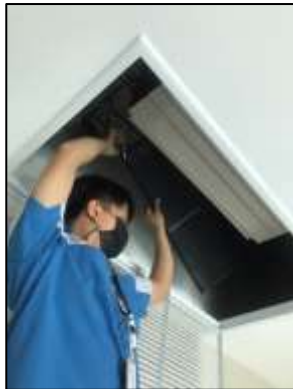
ภาพที่ 4 กิจกรรมทำความสะอาดระบบปรับอากาศ
