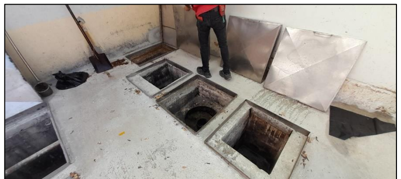
พนักงานทำการตัดไขมันออกจากบ่อดักไขมัน เป็นประจำทุกวัน
