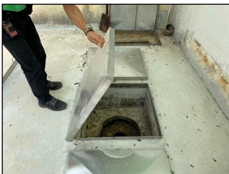
พนักงานทำการตัดไขมันออกจากบ่อดักไขมัน เป็นประจำทุกวัน
