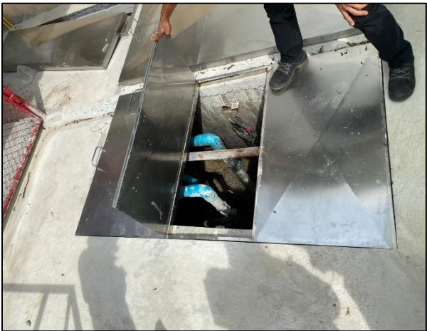
บ่อหน่วงน้ำและบ่อตรวจวัดคุณภาพน้ำของโครงการ
