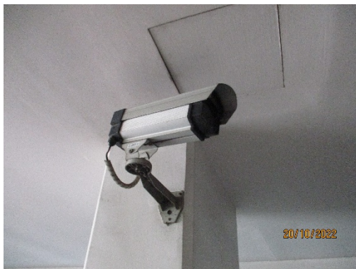
รูปที่ 40 ระบบโทรทัศน์วงจรปิด (CCTV System)
