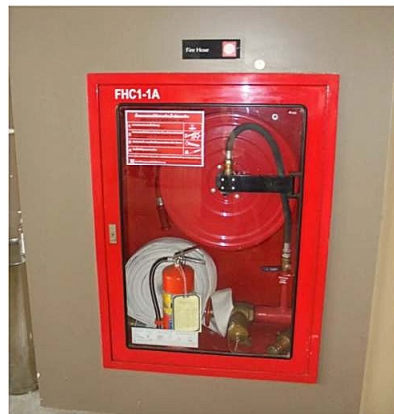
ภาพที่ 3-19 ตู้เก็บสายฉีดน้ำดับเพลิงและอุปกรณ์
