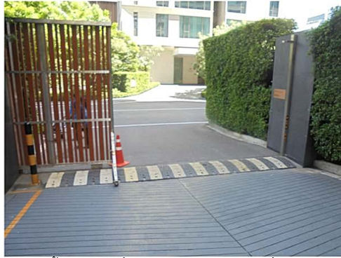
ภาพที่ 3-7 ติดตั้งสັນนูนไว้ที่ถนนด้านหน้าโครงการเพื่อชะลอความเร็วรถ
