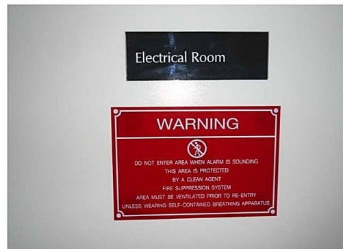
ภาพที่ 3-18 ป้ายเตือนอันตรายหน้าห้องเครื่องไฟฟ้า
