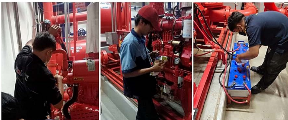
ภาพที่ 3-17 ห้องเครื่องสูบน้ำดับเพลิง และการตรวจสอบระบบ Fire Pump
