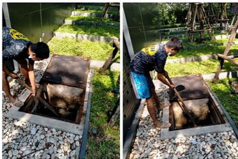
ภาพที่ 3-40 ขุดลอกที่ระบายน้ำและบ่อน้ำ
