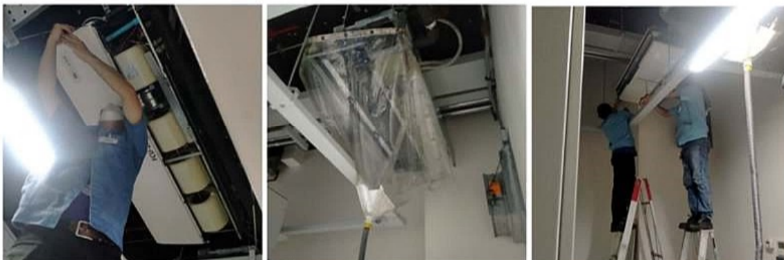
ภาพที่ 3-42 ล้างเครื่องปรับอากาศภายในอาคาร
