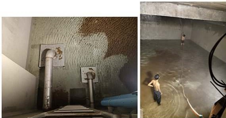
ภาพที่ 3-39 ล้างถังสำรองน้ำใช้
