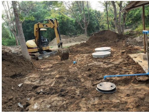
รูปที่ 42 ระบบบำบัดน้ำเสีย
