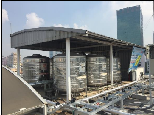
ภาพที่ 10 ถังเก็บน้ำได้ดินชั้นดาดฟ้า
