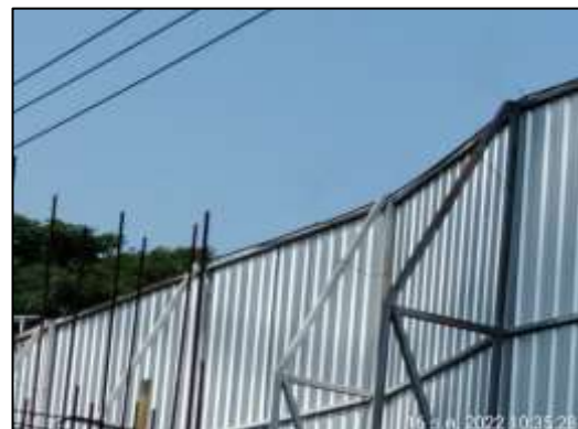
ภาพที่ 11 สเปรย์น้ำบริเวณรั้ว Metal Sheet
