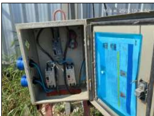
ภาพที่ 43 (ต่อ) ตู้ไฟฟ้าชั่วคราวพร้อมการตรวจสอบ
