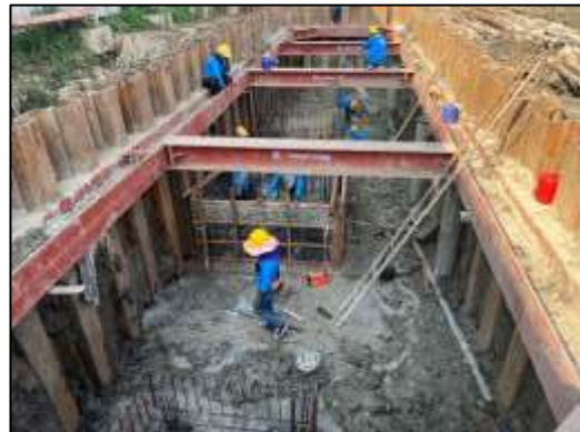
ภาพที่ 40 Sheet Pile และระบบค้ำยัน
