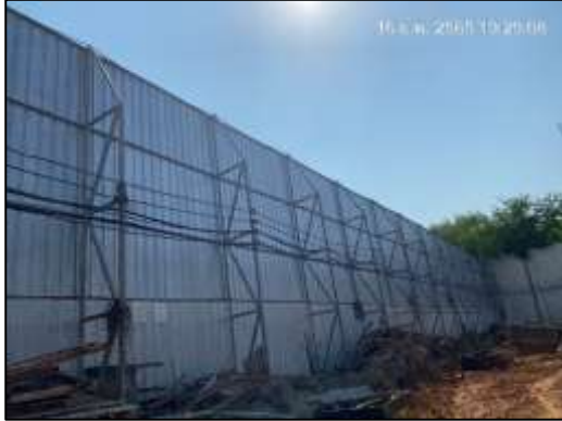
ภาพที่ 3 (ต่อ) รั้ว Metal Sheet สูง 6 เมตร
