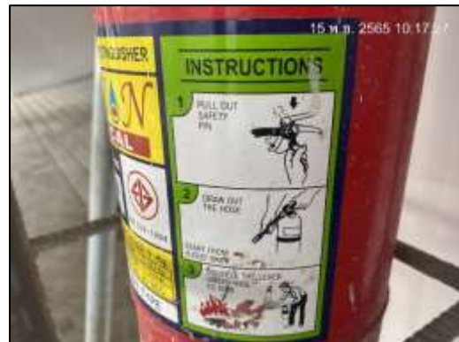
ภาพที่ 31 (ต่อ) ถังดับเพลิงพร้อมป้ายแนะนำการใช้งาน
