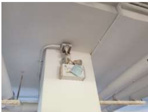
รูปที่ 3-32 ไฟฉุกเฉินอัตโนมัติชนิดแบตเตอรี่แห้ง
