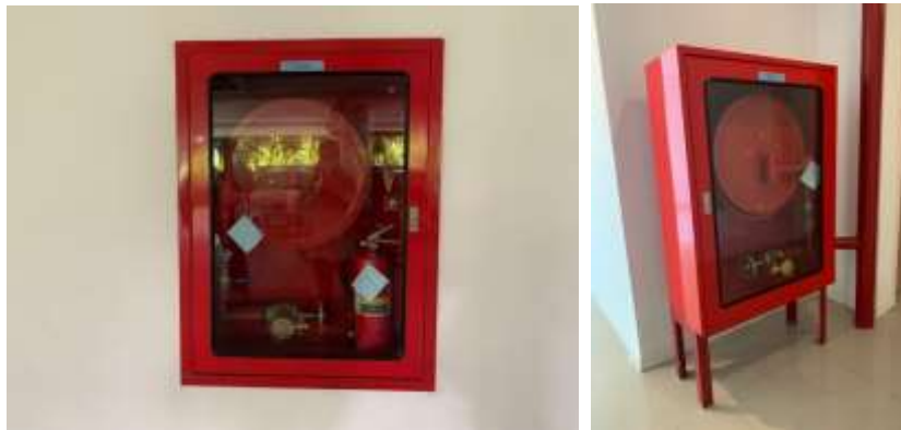
รูปที่ 3-30 ตู้เก็บสายฉีดน้ำดับเพลิงพร้อมอุปกรณ์ (Fire Hose Cabinet : FHC)
