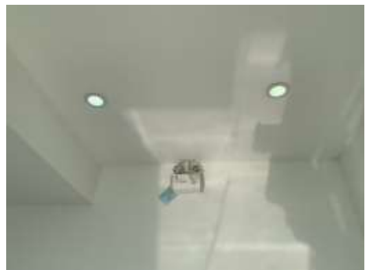
รูปที่ 3-32 ไฟฉุกเฉินอัตโนมัติชนิดแบตเตอรี่แห้ง
