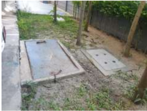
รูปที่ 3-19 บ่อหน่วงน้ำและรางระบายน้ำ
