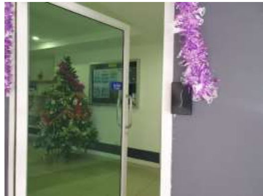
รูปที่ 3-44 ติดตั้งระบบ access control ด้วยระบบ keycard บริเวณประตู ทางเข้า-ออกอาคาร
