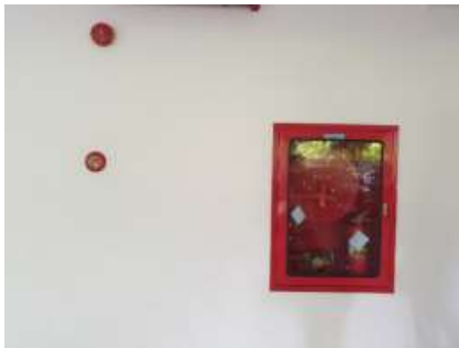
รูปที่ 3-33 อุปกรณ์แจ้งเหตุไฟไหม้กริ่งส่งสัญญาณเตือนอัคคีภัย (Fire Alarm Bell) และแผงควบคุม (Manual Station)
