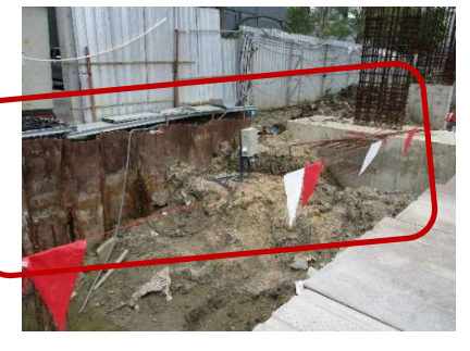
รูปที่ 8 แผงกันดิน (Sheet Pile)
