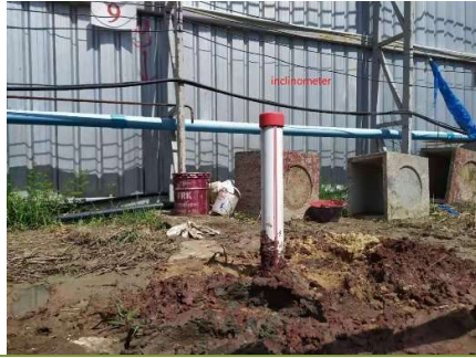
รูปที่ 10 การติดตั้ง Inclinometer
