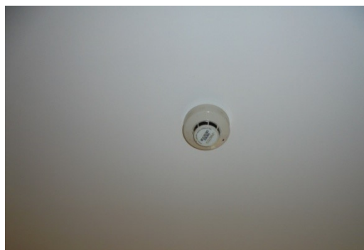
ภาพที่ 4-20 Smoke Detector
