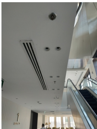
ภาพที่ 5-27 อุปกรณ์ดับเพลิง หัวกระจายน้ำดับเพลิงอัตโนมัติ ระบบท่อเย็นและตู้เก็บสายฉีดน้ำดับเพลิง
