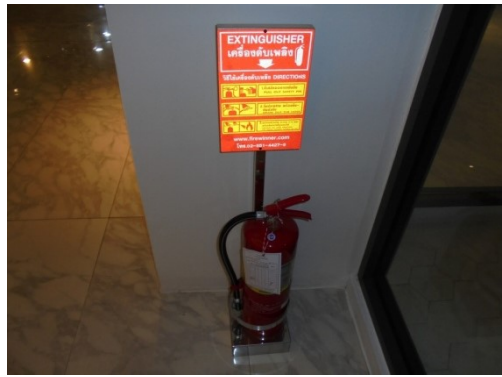
ภาพที่ 5-23 ถังเคมีดับเพลิงพร้อมป้ายบอกวิธีการใช้งาน
