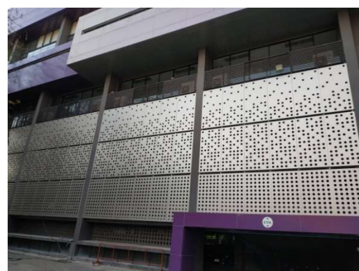
ภาพที่ 5-5 ช่องเปิดระบายอากาศของอาคารจอดรถ
