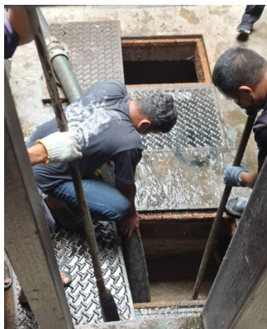
ภาพที่ 5-31 ดูตะกอนที่บ่อเก็บตะกอนของระบบบำบัดน้ำเสีย
