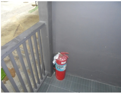
ภาพที่ 5-23 ถังเคมีดับเพลิงพร้อมป้ายบอกวิธีการใช้งาน
