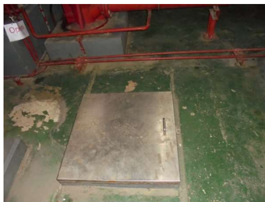
ภาพที่ 4-24 สภาพฝาลังสำรองน้ำใต้ดิน ปิดมิดชิดและมีขอบยกสูงจากพื้น
