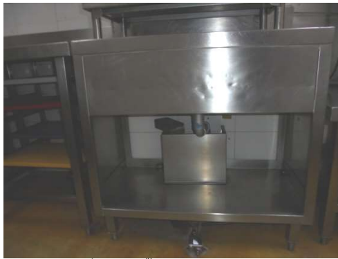
ภาพที่ 4-4 ติดตั้งถังดักไขมันในห้องครัว
