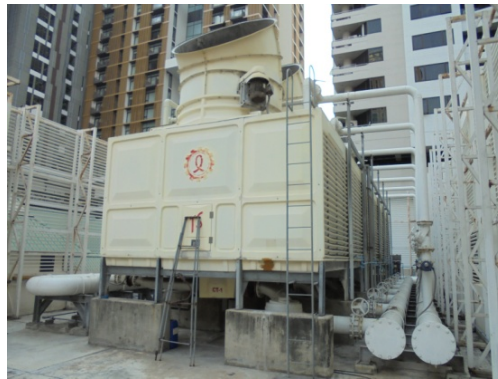
ภาพที่ 4-18 ระบบปรับอากาศแบบรวม Chiller Cooling
