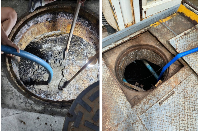
ภาพที่ 4-26 ดูดตะกอนจากบ่อเกรอะ
