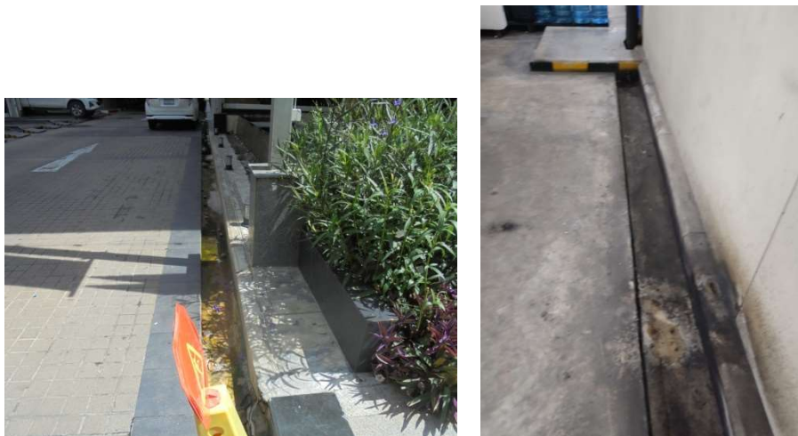
ภาพที่ 4-23 ลอกท่อระบายน้ำ มีตะแกรงดักขยะ ปัจจุบันสามารถระบายน้ำได้เป็นอย่างดี
