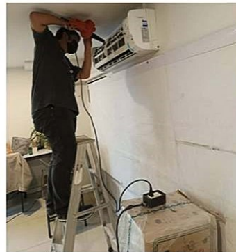
ภาพที่ 6-37 ล้างทำความสะอาดเครื่องปรับอากาศ
