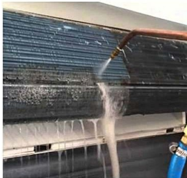
ภาพที่ 6-37 ล้างทำความสะอาดเครื่องปรับอากาศ
