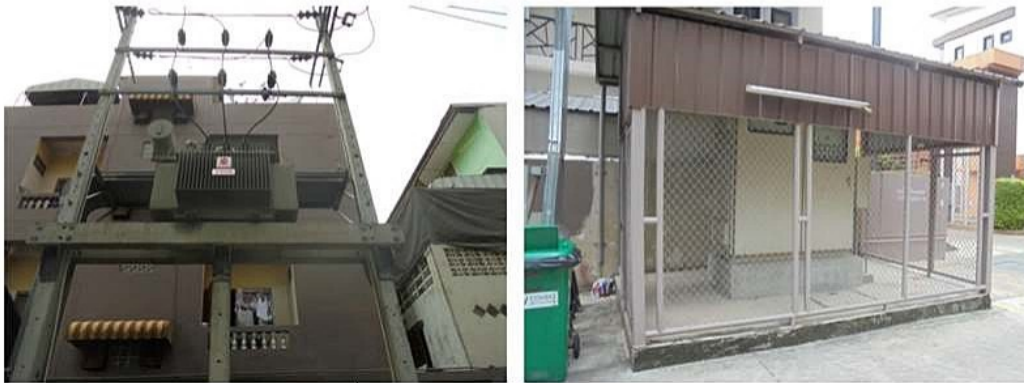
ภาพที่ 6-14 หม้อแปลงไฟฟ้าและห้องไฟฟ้า MDB
