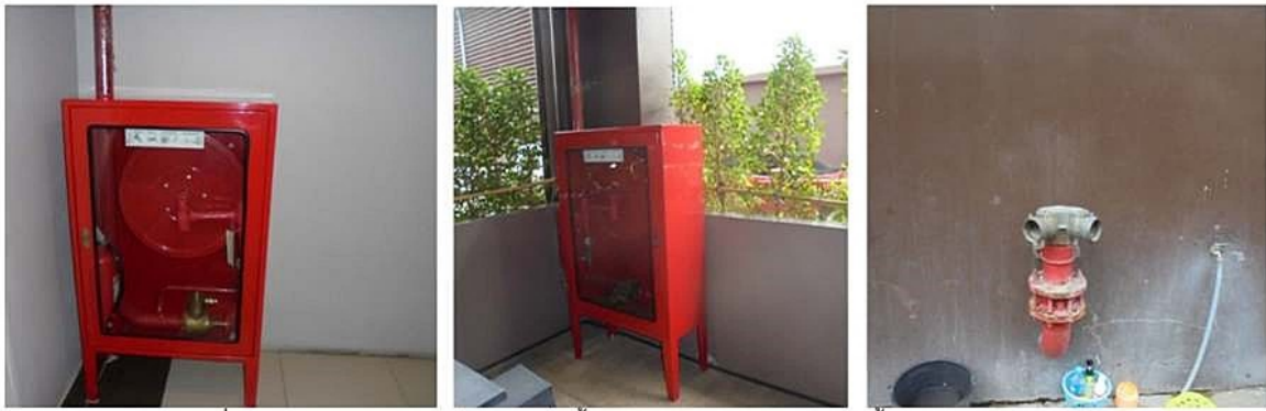
ภาพที่ 6-34 อุปกรณ์ดับเพลิง ตู้เก็บสายฉีดน้ำดับเพลิงพร้อมอุปกรณ์ หัวรับน้ำดับเพลิงจากภายนอก
