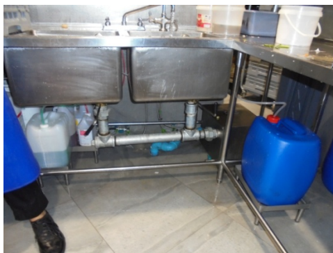
ภาพที่ 3-9 ถังดักไขมันภายในห้องครัว
