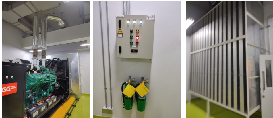
ภาพที่ 3-17 ห้องเครื่องไฟฟ้าสำรอง ติดตั้งระบบกันเสียงดังและอุปกรณ์แจ้งเตือนอัคคีภัยและป้องกันอัคคีภัย
