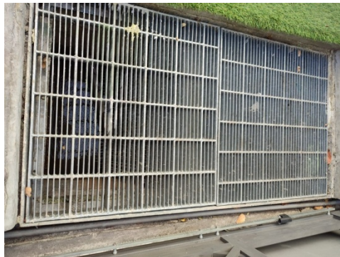
ภาพที่ 3-8 บ่อบำบัดคุณภาพน้ำทิ้ง และตะแกรงดักขยะ
