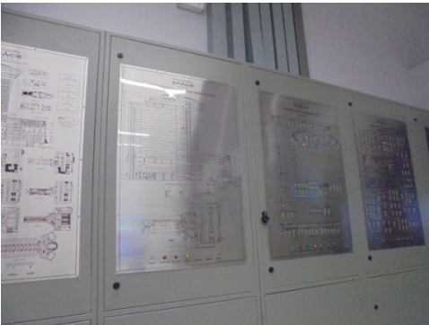
ภาพที่ 3-30 ตู้ควบคุมสัญญาณเตือนอัคคีภัย
