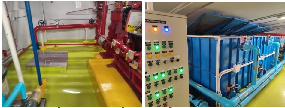
ภาพที่ 3-14 ถึงสำรองน้ำใต้ดิน ฝ้ายกสูงจากพื้นและระบบกรองน้ำประปากรองสูงไปยังส่วนต่าง ๆ
