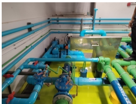
ภาพที่ 3-19 ตรวจสอบระบบท่อส่งน้ำประปา อยู่ในสภาพดี ไม่มีจุดรั่วซึม
