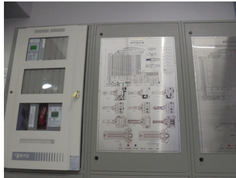
ภาพที่ 3-30 ตู้ควบคุมสัญญาณเตือนอัคคีภัย
