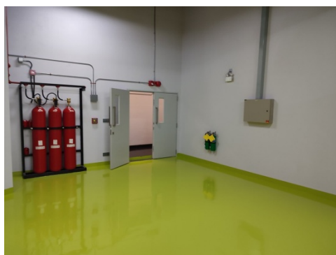
ภาพที่ 3-16 ห้องหม้อแปลงไฟฟ้าติดตั้งอุปกรณ์แจ้งเหตุเพลิงไหม้และอุปกรณ์ดับเพลิง
