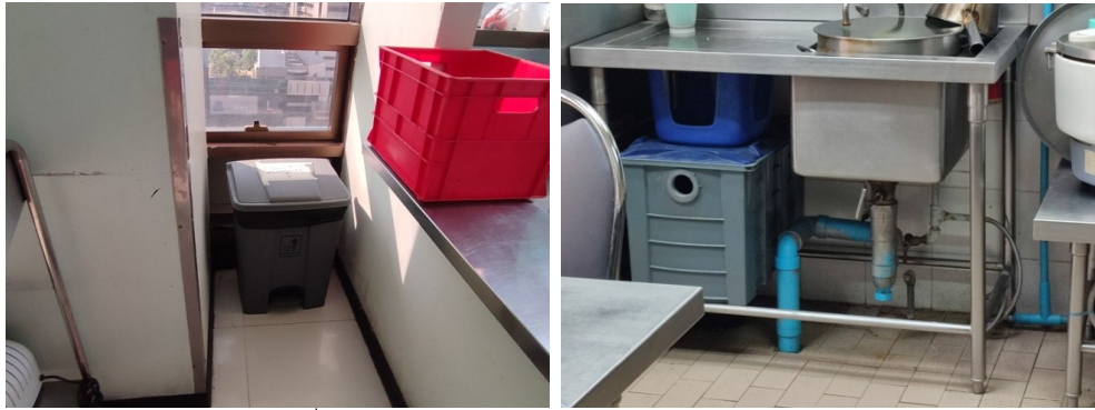
ภาพที่ 4-10 ถังรองรับมูลฝอยขนาด 100 ลิตร และถังดักไขมัน
