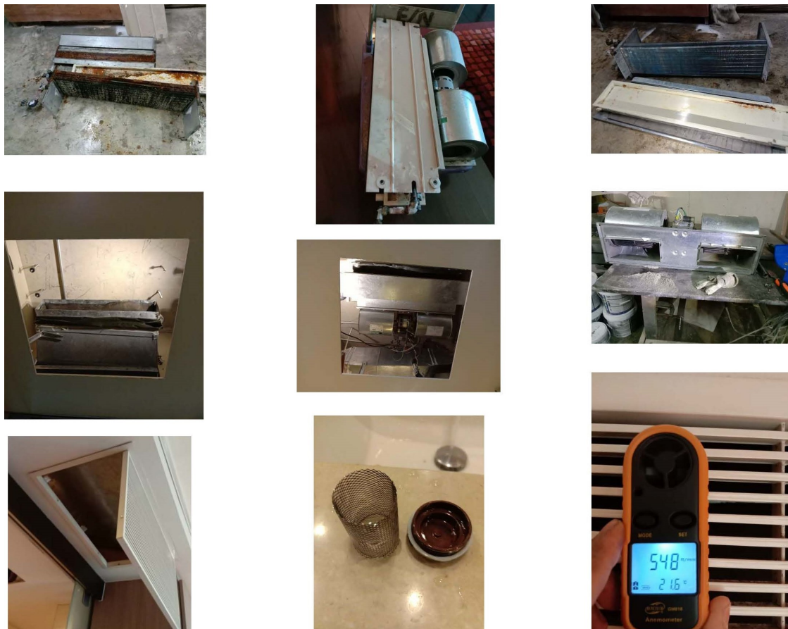
ภาพที่ 4-34 ล้างทำความสะอาดระบบปรับอากาศ
