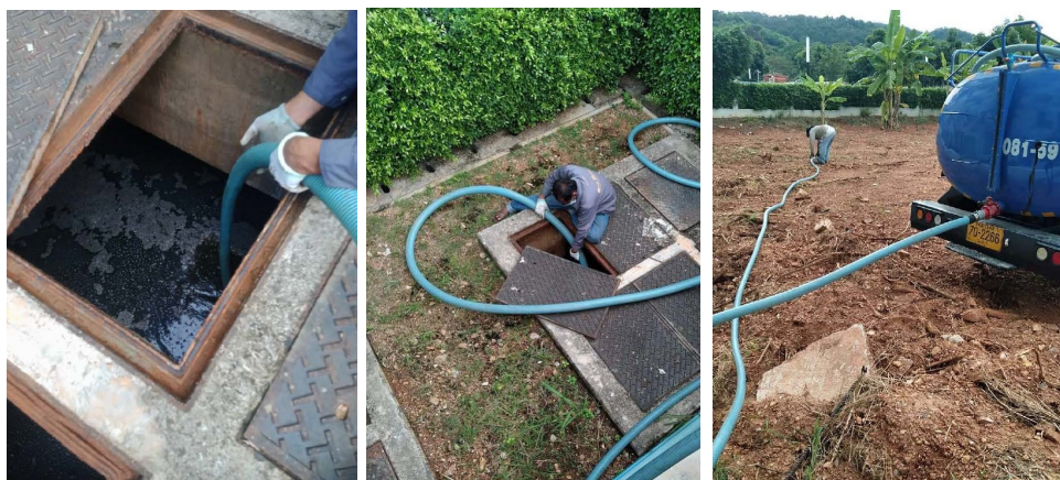
ภาพที่ 4-9 ระบบบำบัดน้ำเสีย บำรุงรักษาระบบบำบัดน้ำเสียและสูบน้ำจากบ่อเก็บตะกอน
