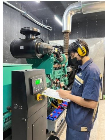
ภาพที่ 3-32 ตรวจสอบระบบไฟฟ้าสำรองฉุกเฉินของโครงการทุกสัปดาห์
