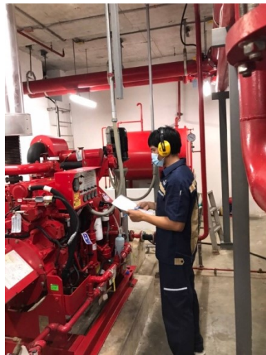
ภาพที่ 3-33 ตรวจสอบระบบดับเพลิง Fire Pump ของโครงการทุกสัปดาห์
