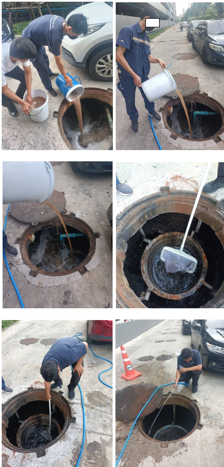
ภาพที่ 3-35 ดูแลรักษาระบบบำบัดน้ำเสียและเติมจุลินทรีย์ในระบบบำบัดน้ำเสีย ตรวจเช็คตะกอนในบ่อเก็บตะกอน
