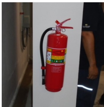
ภาพที่ 3-12 มีวิธีการใช้ติดกับอุปกรณ์ดับเพลิงมือถือ
