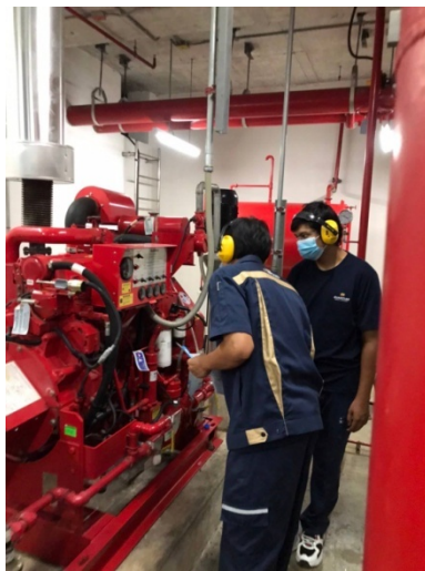
ภาพที่ 3-33 ตรวจสอบระบบดับเพลิง Fire Pump ของโครงการทุกสัปดาห์
