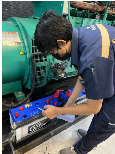
ภาพที่ 3-32 ตรวจสอบระบบไฟฟ้าสำรองฉุกเฉินของโครงการทุกสัปดาห์
