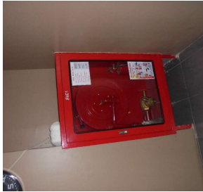
ภาพที่ 4-15 ระบบท่อเชื่อมและตู้เก็บสายชนิดน้ำดับเพลิงพร้อมอุปกรณ์
