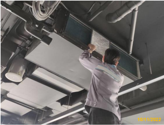
รูปที่ 3-5 การล้างทำความสะอาดเครื่องปรับอากาศ
