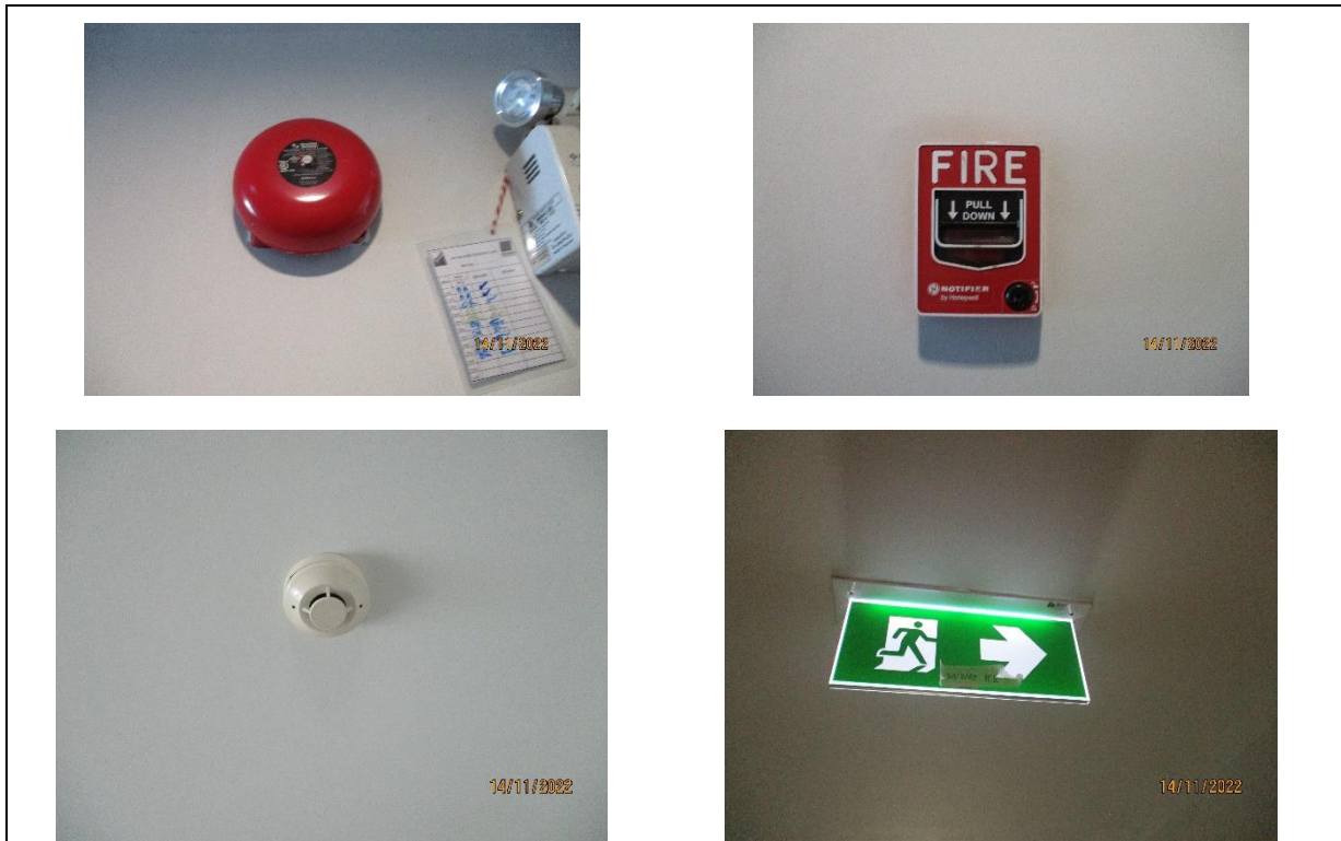
รูปที่ 18 ระบบส่งสัญญาณเตือนเพลิงไหม้
