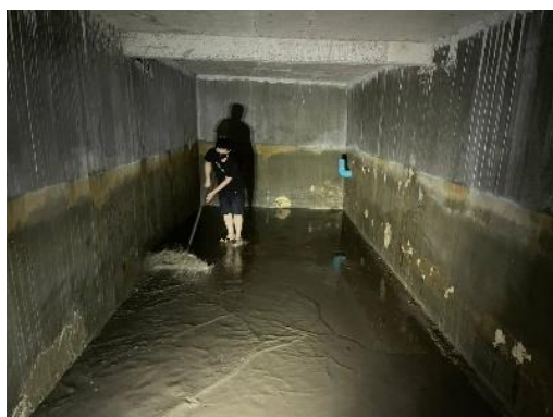
รูปที่ 55 ล้างทำความสะอาดถังสำรองน้ำใช้
