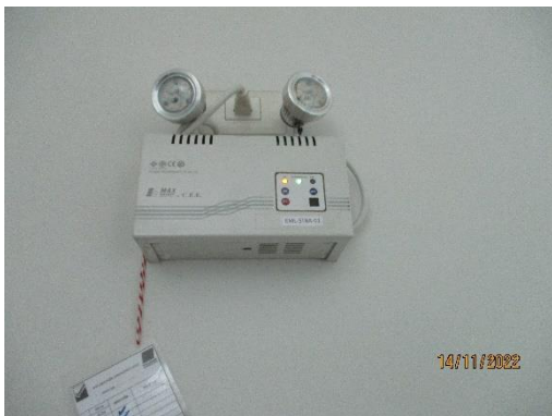
รูปที่ 23 ไฟส่องสว่างฉุกเฉิน
