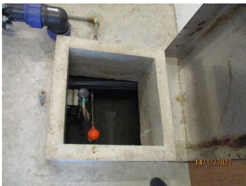
รูปที่ 12 ถังสำรองน้ำชั้นตาดฟ้า และชั้นใต้ดิน
