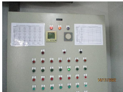
รูปที่ 6 มิเตอร์ไฟฟ้าสำหรับระบบบำบัดน้ำเสีย
