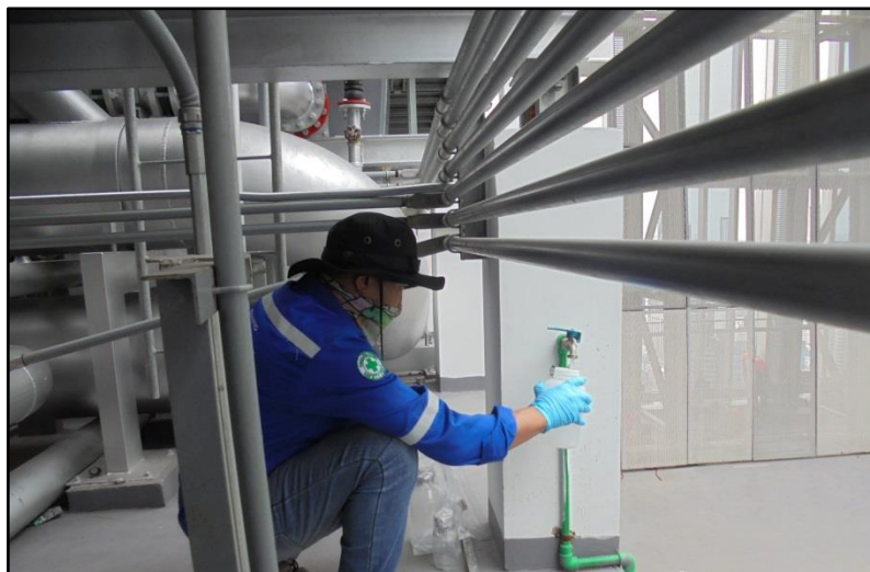
รูปที่ 3.2-1 จุดตรวจวัดคุณภาพน้ำจากหอผึ่งเย็น บริเวณจุดที่น้ำไหลเข้ามาเดิมระบบ ในวันที่ 7 ธันวาคม พ.ศ. 2565
