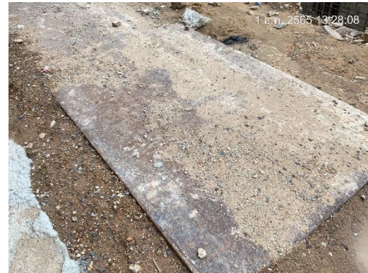
ภาพที่ 20 ปูแผ่นเหล็กภายในพื้นที่โครงการ
