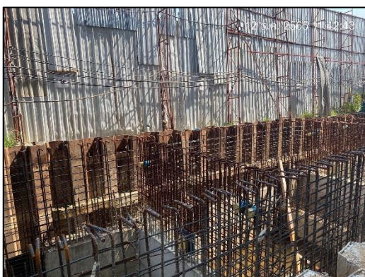
ภาพที่ 22 กัด Sheet pile ป้องกันดินพัง
