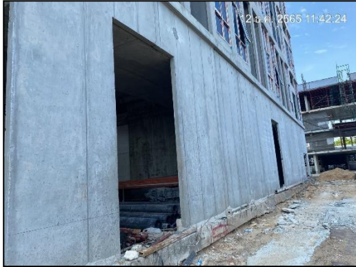
ภาพที่ 14 เทคนิคการก่อสร้างสำเร็จรูป
