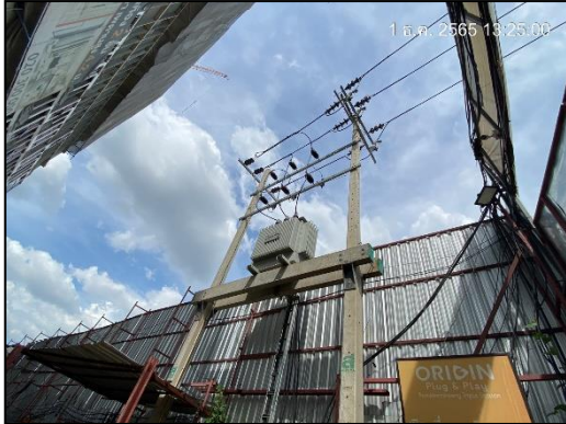
ภาพที่ 37 หม้อแปลงไฟฟ้า
