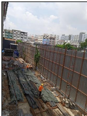
ภาพที่ 8 ผ้าใบปิดคลุมกองวัสดุก่อสร้าง
