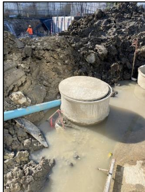
ภาพที่ 29 บ่อดักตะกอน และท่อระบายน้ำ
