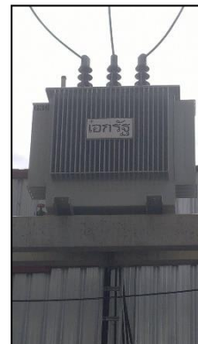
ภาพที่ 39 หม้อแปลงไฟฟ้า
