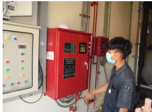
ตรวจสอบระบบ Fire Pump ใช้งานได้ปกติ
