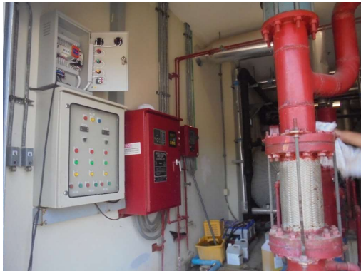
ตรวจสอบระบบ Fire Pump ใช้งานได้ปกติ
