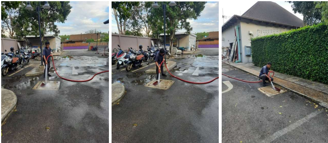
ภาพที่ 3-45 ล้างทำความสะอาดที่ระบายน้ำ ให้การระบายน้ำดี ไม่มีขยะอุดตัน
