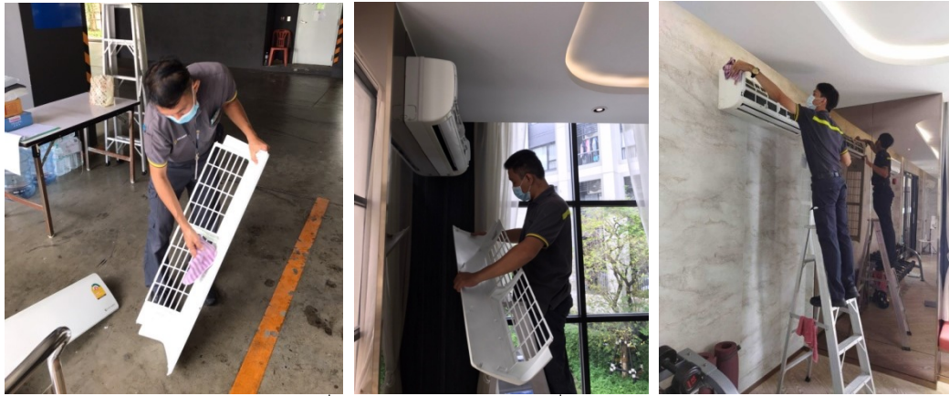
ภาพที่ 3-27 ล้างทำความสะอาดเครื่องปรับอากาศ
