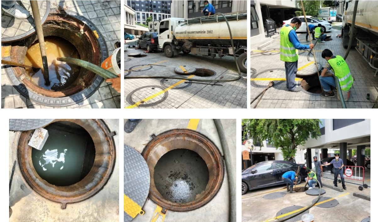
ภาพที่ 3-31 ซ่อมบำรุงระบบบำบัดน้ำเสีย สูบตะกอนไขมันและสูบตะกอนบ่อเกรอะ และระหว่างดำเนินการใช้ขวยกัน และดำเนินการในช่วงเวลากลางวัน
