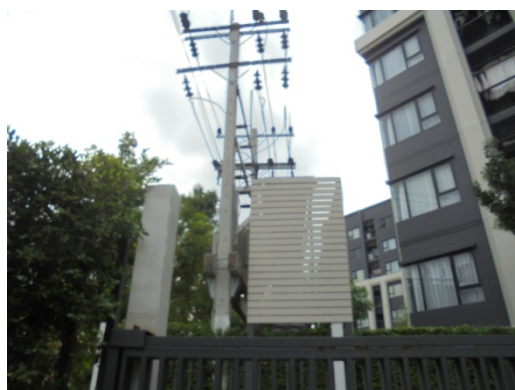
ภาพที่ 3-15 หม้อแปลงไฟฟ้าและจัดทำระแนงกันระหว่างห้องพักและหม้อแปลงไฟฟ้า
