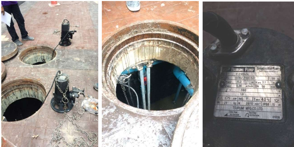
4-45 Submersible Pumpใช้จริง 1 ชุดและสำรองไว้ 1 ชุด (Sparepart)
