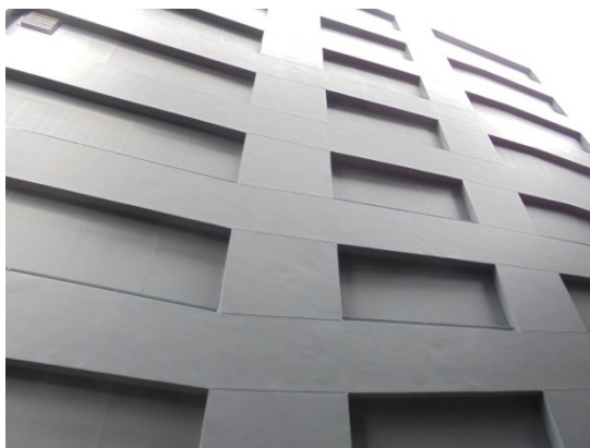
ภาพที่ 4-51 ปรับปรุงผนังอาคารจอดรถด้านทิศใต้ของอาคาร เป็นผนังกันเสียง ปิดทับป้องกันผลกระทบด้านเสียงจากอาคารจอดรถ ไปยังอาคาร ฟิเอสเจ อพาร์ทเมนต์ และอาคาร โรงแรม คราวน์ บีทีเอส นานา
