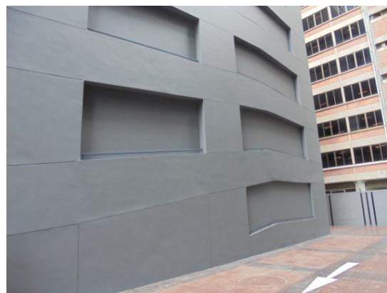
ภาพที่ 4-51 ปรับปรุงผนังอาคารจอดรถด้านทิศใต้ของอาคาร เป็นผนังกันเสียง ปิดทับป้องกันผลกระทบด้านเสียงจากอาคารจอดรถ ไปยังอาคาร ฟิเอสเจ อพาร์ทเมนต์ และอาคาร โรงแรม คราวน์ บีทีเอส นานา
