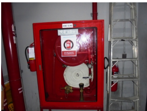
ภาพที่ 4-23 ตู้เก็บสายฉีดน้ำดับเพลิงพร้อมอุปกรณ์ และเครื่องสูบน้ำดับเพลิง
