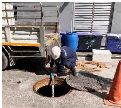
ภาพที่ 4-8 สูบตะกอนออกจากบ่อเกรอะและล้างเก็บตะกอน
