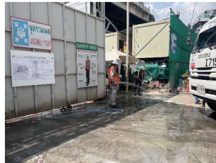
รูปที่ 51 การฉีดล้างล้อก่อนออกจากบริเวณพื้นที่โครงการ
