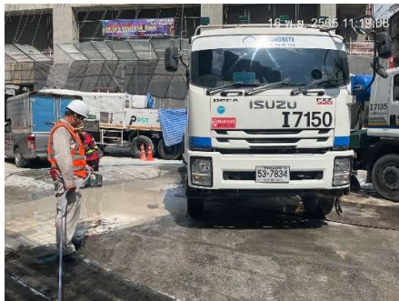
รูปที่ 51 การฉีดล้างล้อก่อนออกจากบริเวณพื้นที่โครงการ
