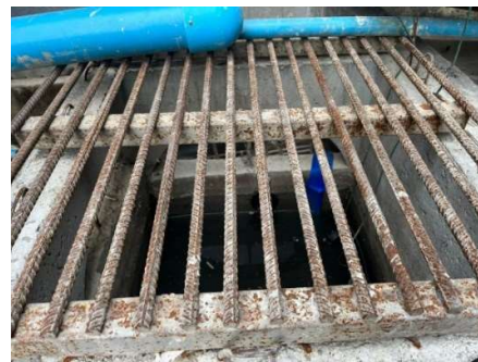
รูปที่ 65 ตะแกรงดักขยะ
