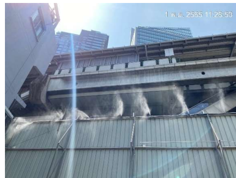
รูปที่ 3 ระบบสเปรย์น้ำบริเวณแนวรั้วรอบโครงการ
