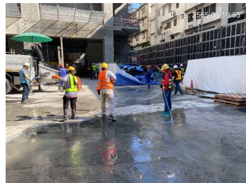
รูปที่ 4 การฉีดพรมน้ำภายในพื้นที่ก่อสร้าง
