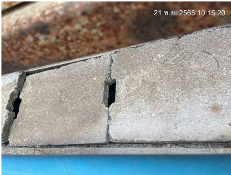
รูปที่ 27 รางระบายน้ำรอบพื้นที่โครงการ
