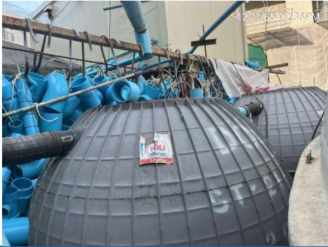
รูปที่ 22 ถึงบำบัดน้ำเสียสำเร็จรูป
