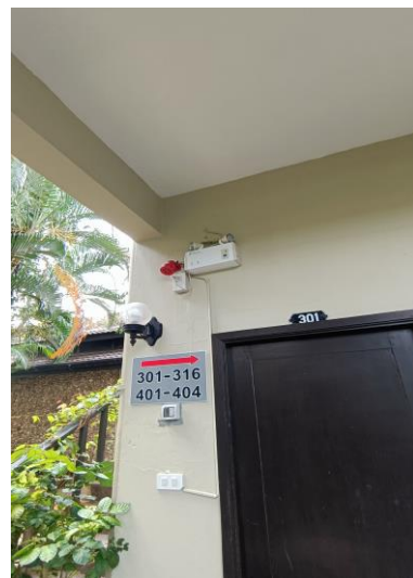
ภาพที่ 44 แสดงไฟส่องสว่างฉุกเฉิน
