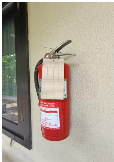
ภาพที่ 40 แสดงถังดับเพลิงพร้อมบันทึกการตรวจสอบ
