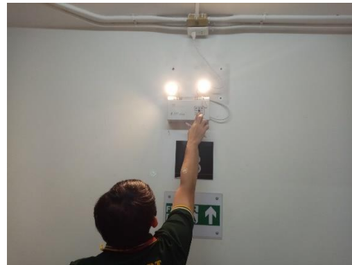
ภาพที่ 52 แสดงตรวจเช็คระบบไฟฉุกเฉิน
