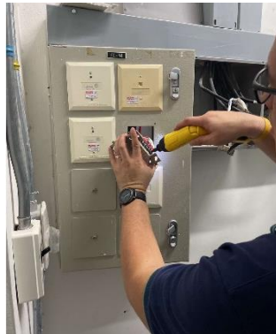
ภาพที่ 45 แสดงการตรวจเช็คระบบ Fire Alarm
