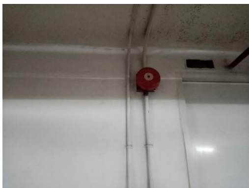
ภาพที่ 37 แสดงสัญญาณเตือนภัย (Alarm Bell)
