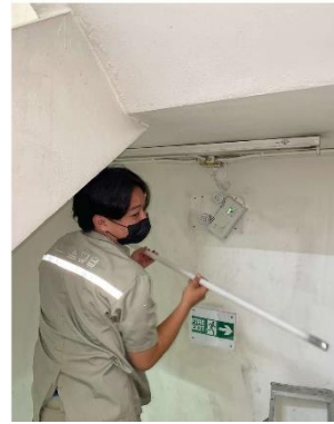
ภาพที่ 66 แสดงการเปลี่ยนหลอดไฟส่องสว่าง
