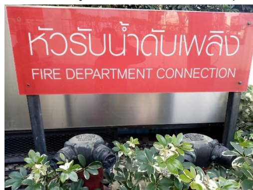
ภาพที่ 32 แสดงหัวรับน้ำดับเพลิงจากภายนอก
