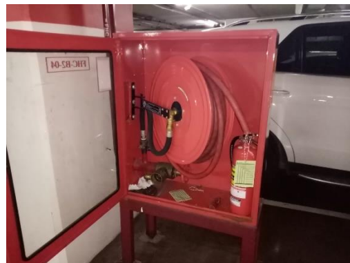
ภาพที่ 30 แสดงตู้เก็บสายฉีดสายดับเพลิงพร้อมอุปกรณ์
