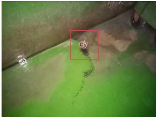
ภาพที่ 27 แสดงร่องรอยน้ำเสียจากห้องพักขยะ
