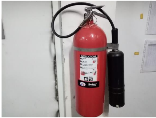
ภาพที่ 33 แสดงถังดับเพลิง CO 2 ภายในห้องต่างๆ
