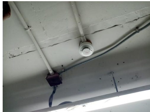
ภาพที่ 36 แสดงเครื่องตรวจจับควัน (Smoke Detector)
