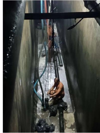
ภาพที่ 18 แสดงการล้างบ่อน้ำบาดน้ำเสีย
