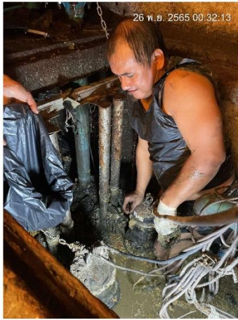
ภาพที่ 17 แสดงการคัดตะกอนจากบ่อน้ำเสีย
