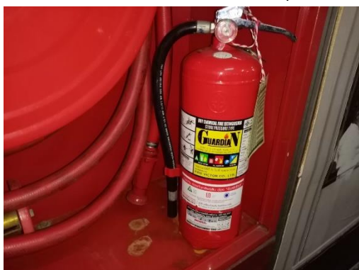
ภาพที่ 31 แสดงถังดับเพลิงชนิด ABC ติดตั้งในตู้ FHC
