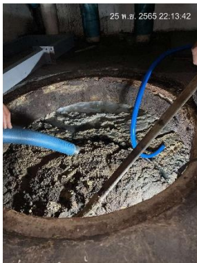
ภาพที่ 19 แสดงการดูดไขมันจากบ่อดักไขมัน
