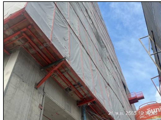
ภาพที่ 61 ใช้ Protection ป้องกันวัสดุร่วงหล่น
