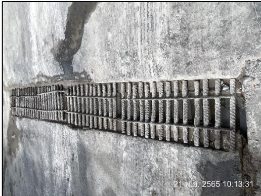
ภาพที่ 37 รางระบายน้ำ และตะแกรงดักขยะ
