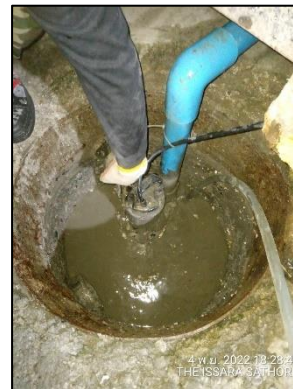
ภาพที่ 40 ปั่นน้ำ และท่อสูบน้ำขึ้นใต้ดิน
