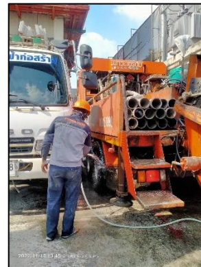
ภาพที่ 19 ล้างล้อก่อนออกนอกพื้นที่โครงการ
