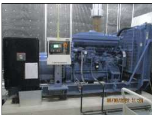
รูปที่ 1-7 เครื่องกำเนิดไฟฟ้า
