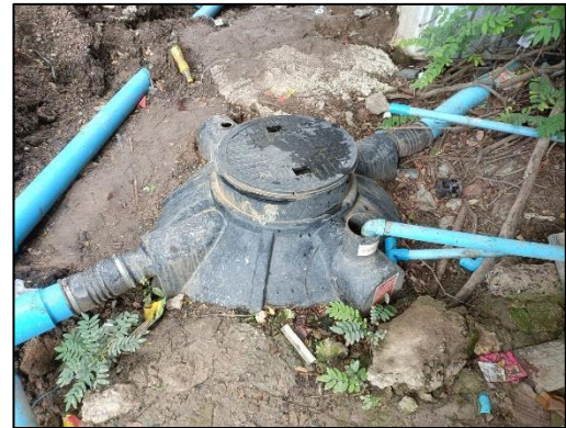
ภาพที่ 42 ระบบบำบัดน้ำเสียสำเร็จรูป
