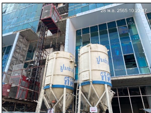
ภาพที่ 22 ปูนคอนกรีตสำเร็จรูป และพื้นที่เก็บปูนซีเมนต์ผง
