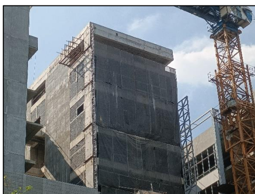
ภาพที่ 28 ผ้าใบกันฝุ่น (Mesh Sheet)
