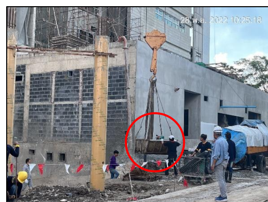
ภาพที่ 29 กระบะบรรจุทุกลักษณะวัสดุลงจากอาคาร
