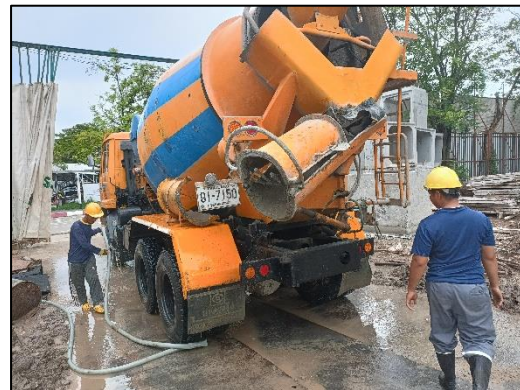
ภาพที่ 31 กิจกรรมล้างล้อรถก่อนออกจากโครงการ
