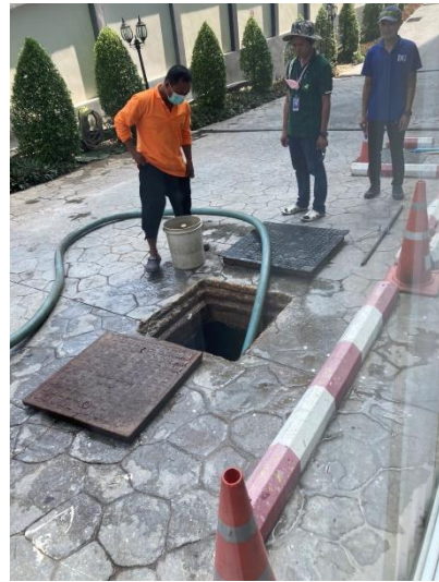
ภาพที่ 8 แสดงการสูบน้ำจากบ่อน้ำบาดาลเสีย
