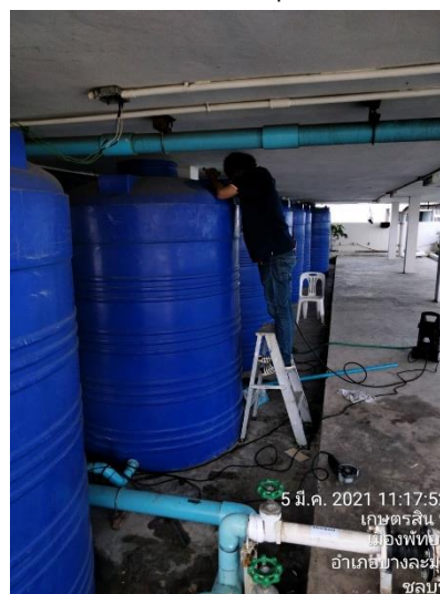
ภาพที่ 16 แสดงการล้างถังเก็บถังน้ำสำรองคาบฟ้า
