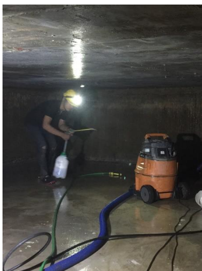
ภาพที่ 15 แสดงการล้างถังเก็บถังน้ำสำรองใต้ดิน
