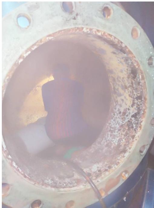
ภาพที่ 6 แสดงการทำความสะอาดถังเก็บน้ำ
