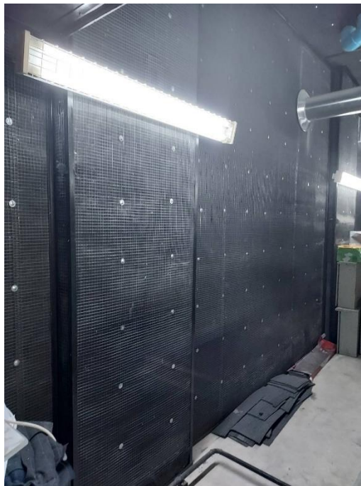
ภาพที่ 40 แสดงอุปกรณ์ซับเสียงของห้องเครื่องปั่นไฟ
