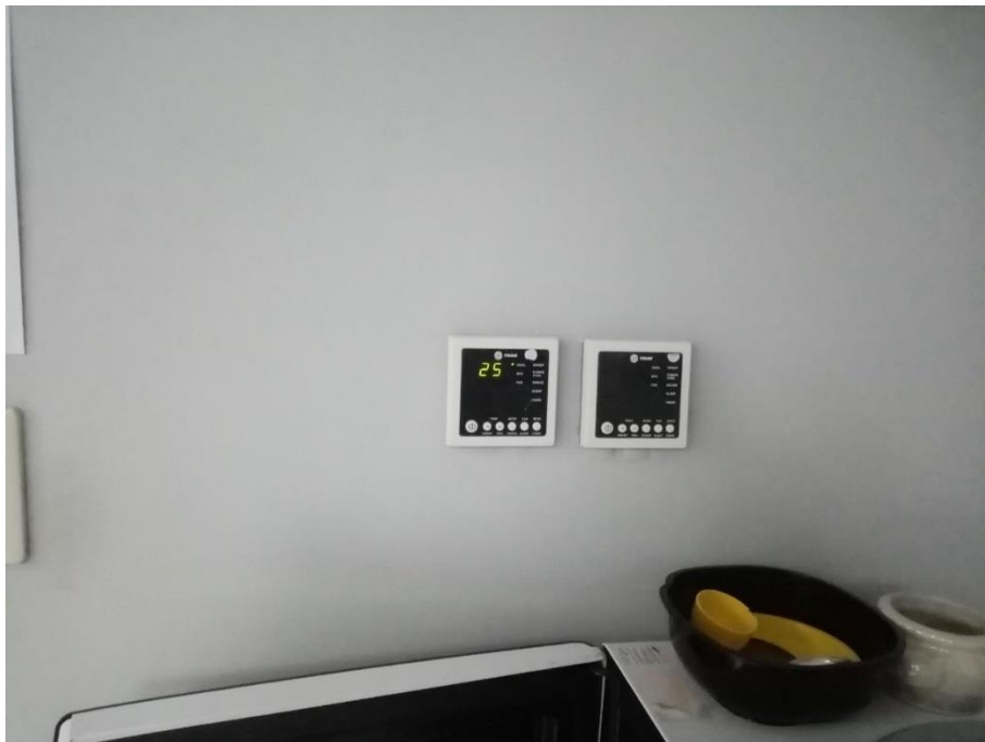
ภาพที่ 28 แสดงตัวตั้งอุณหภูมิเครื่องปรับอากาศ 25 °C
