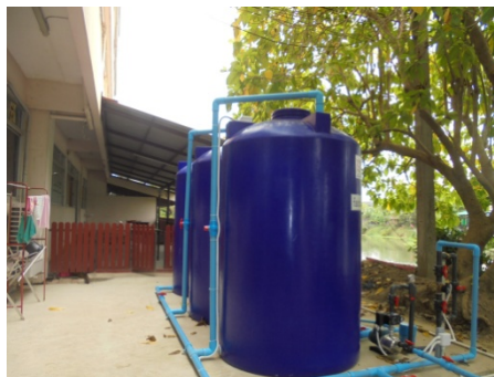
ภาพที่ 5-27 ถังสำรองน้ำใช้ และระบบประปา
