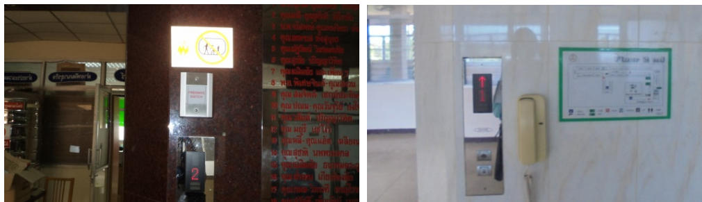
ภาพที่ 5-11 สัญญาณเตือนเพลิงไหม้แบบกริ่ง (Fire Alarm Bell) ติดตั้งไว้บริเวณหน้าลิฟท์ และป้ายบอกตำแหน่งทางหนีไฟ
