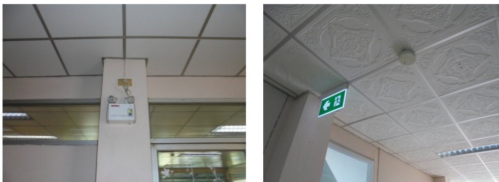
ภาพที่ 5-13 ติดตั้งไฟส่องสว่างฉุกเฉินบริเวณบันไดหนีไฟและทางออกบันไดหนีไฟ และป้ายบอกทางหนีไฟเรืองแสง
