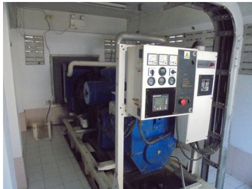
ภาพที่ 5-25 ท่อไอเสียเครื่องกำเนิดไฟฟ้าสำรอง ห้องเครื่องไฟฟ้าและห้องเครื่องไฟฟ้าสำรอง
