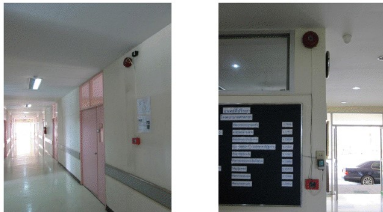
ภาพที่ 5-16 ติดตั้งระบบแจ้งเหตุแบบใช้มือ (Manual Station) และ Alarm Bell บริเวณโถงทางเดินชั้น 1 และ 2 ของอาคาร
