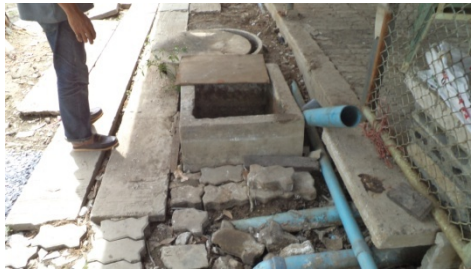
ภาพที่ 5-7 บ่อดักไขมันอยู่บริเวณห้องครัวของโครงการ ดักตะกอนไขมันออกทุกสัปดาห์
