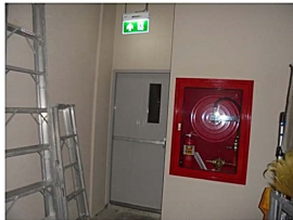
ภาพที่ 3-18 ท่อขึ้นและตู้เก็บสายฉีดน้ำดับเพลิงและอุปกรณ์
