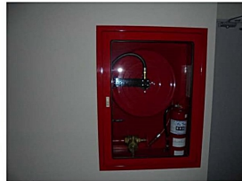
ภาพที่ 3-18 ท่อขึ้นและตู้เก็บสายฉีดน้ำดับเพลิงและอุปกรณ์
