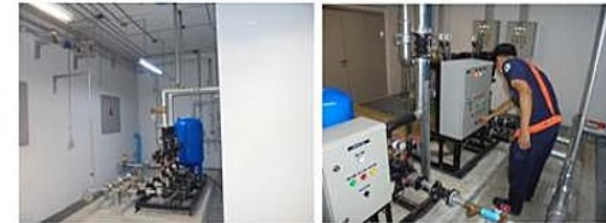
ภาพที่ 3-7 ห้องเครื่องปั๊มน้ำ และช่างโครงการตรวจสอบระบบปั๊มน้ำและถังต่าง ๆ
